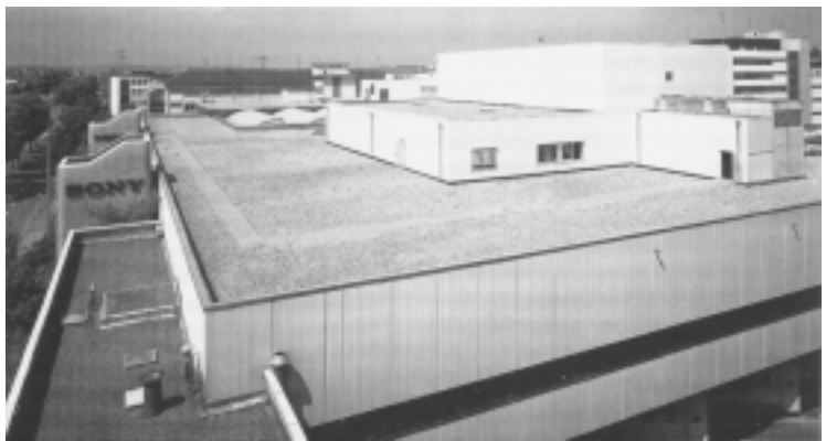
Das fertiggestellte Bauwerk
